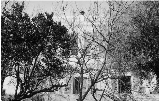
La maison de Nice en travaux
